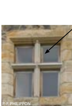
fenêtre à meneau du château de Montluçon
