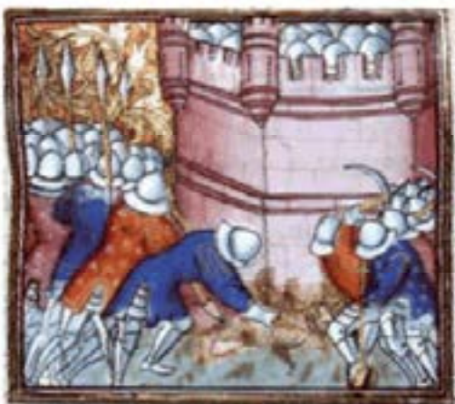
L'attaque d'un château au XIVe siècle : des soldats creusent une tranchée pour faire écrouler la muraille
