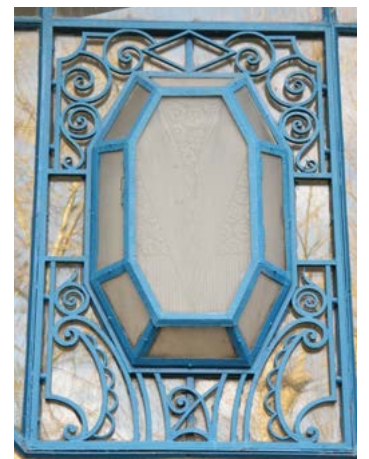
Détail d'éclairage à Vichy
