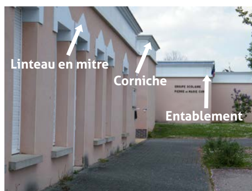
Groupe scolaire Pierre et Marie Curie à Montmarault et son « post-modernisme » puisant dans les références anciennes
