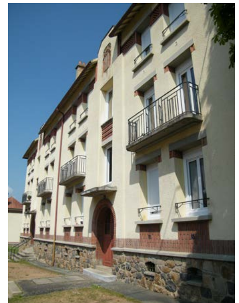
Cité des Guineberts à Montluçon
