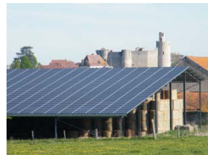
Stabulation équipée de panneaux photovoltaïques à Billy
