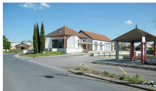
Ensemble mairie/salle des fêtes à Toulon-sur-Allier
