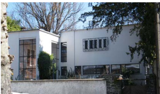
Villa à Moulins reprenant les principes du mouvement moderne : toit-terrasse, murs lisses et blancs, grandes baies vitrées
