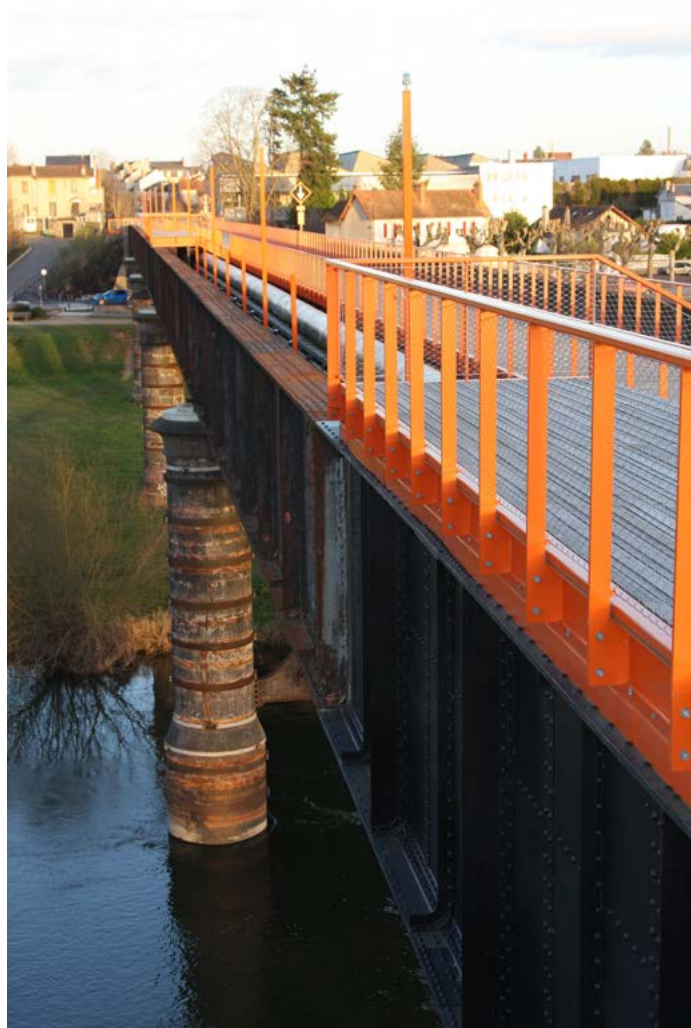
La passerelle du pont de fer à Moulins
