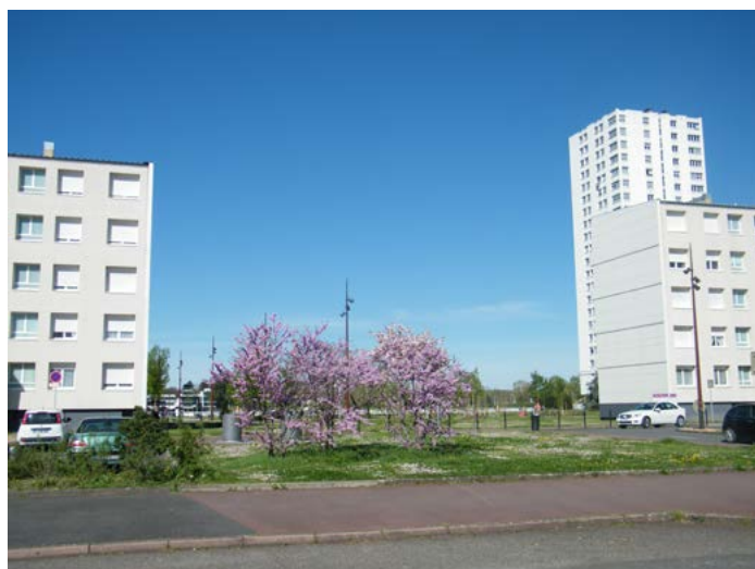
La percée créée par la «déconstruction» partielle de la barre des Ailes à Vichy
