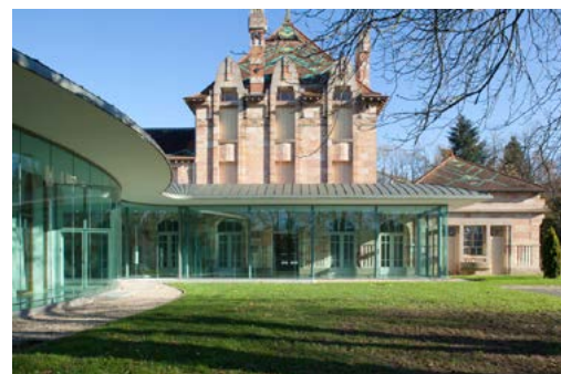
Extension de la gare de Nérès-les-Bains
