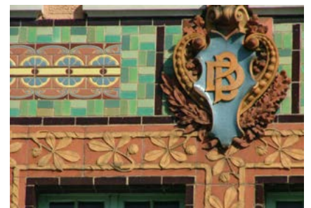
Détail d'ornementation éclectique à Montluçon
