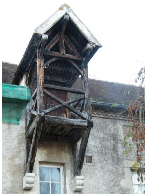
Monte-sac au moulin du Chambon, Cusset
