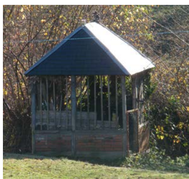
Abri à pans de bois, Arfeuilles
